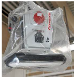
Strom- und Lufttampel für die Mechanikerplätze.
